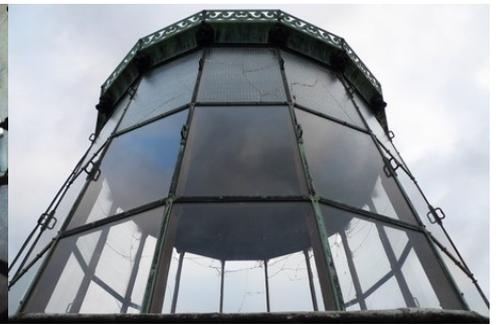
La verrière à structure en fonte et laiton
